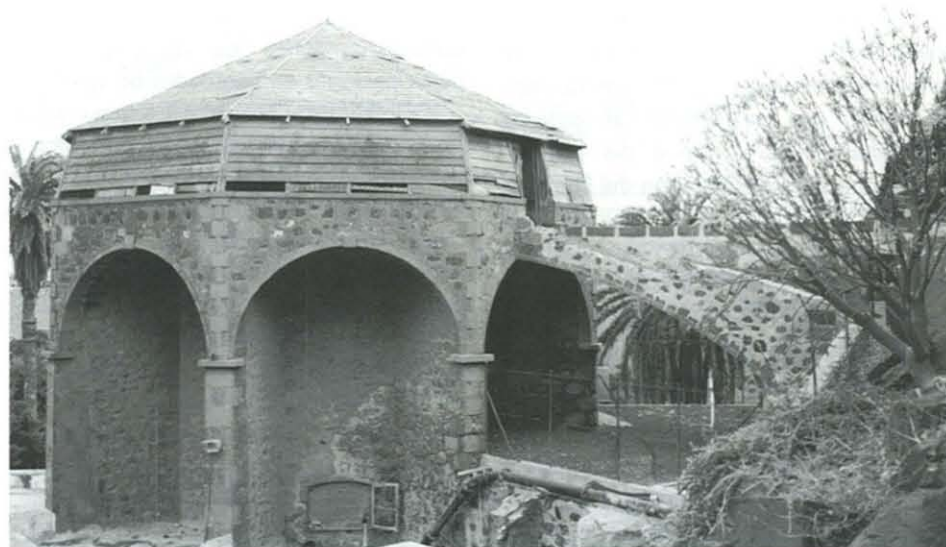
Figura 7. Detalle del arbotante y acceso a la plataforma superior de la noria y estanque regulador
