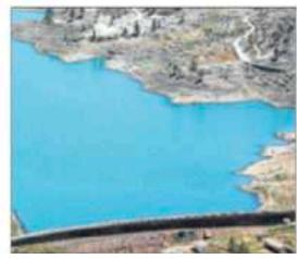
**Cota.** Con una diferencia de cota de 400 metros, las presas de Chira y Soria conformarán la central hidroeléctrica reversible mediante la inclusión de tres grupos de 50 megavatios, los cuales, con una combinación adecuada –dos producirán energía y otro bombeará– podrán servir para equilibrar la curva de demanda energética de Gran Canaria.
