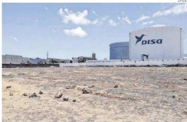
Terrenos en Salinetas donde se prevé instalar una planta eléctrica de gas propano.
